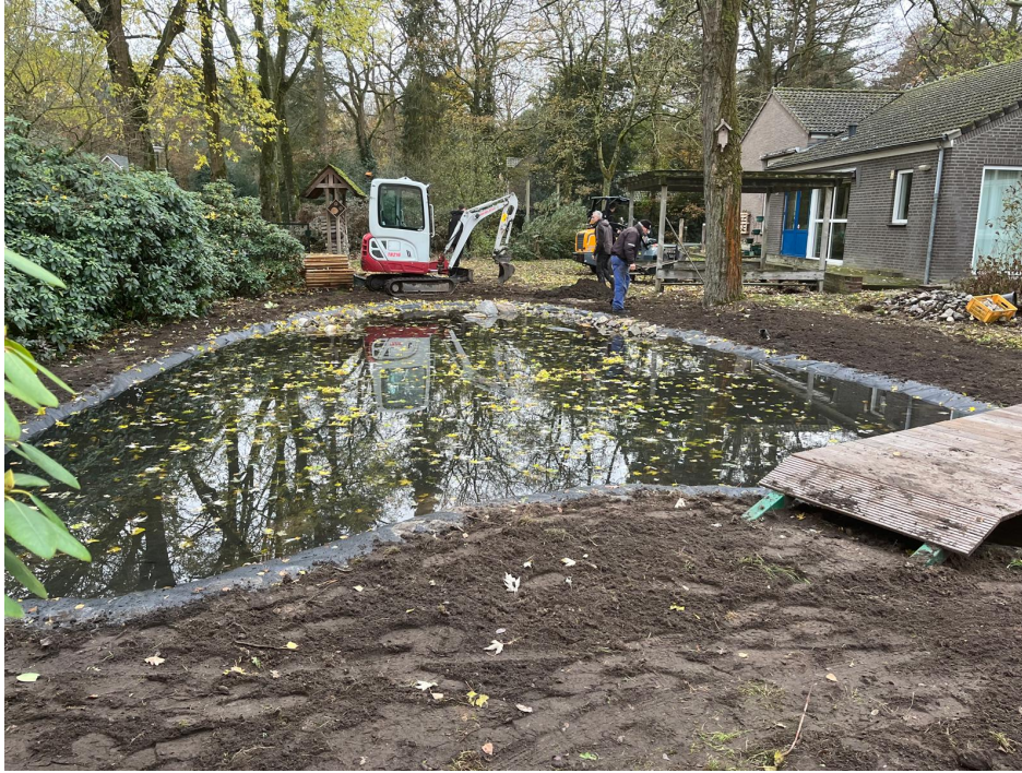
Martijn Pauly heeft folie geplaatst en het terrein effen gemaakt.
